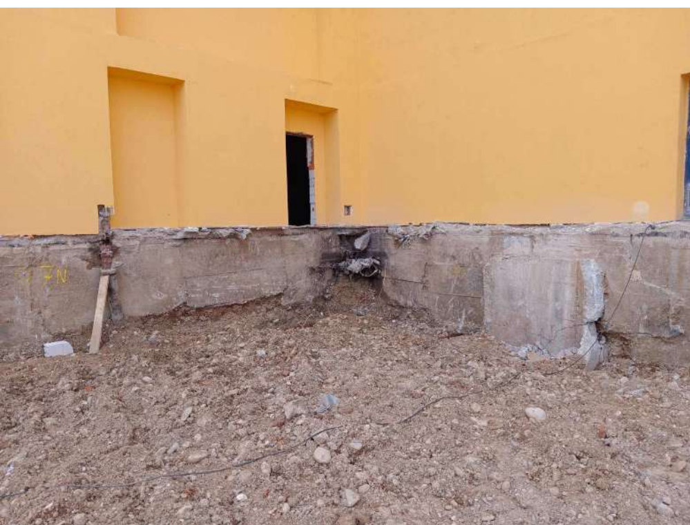
Слика 2. Постојећа конструкција објекта чије се помјерање прати
