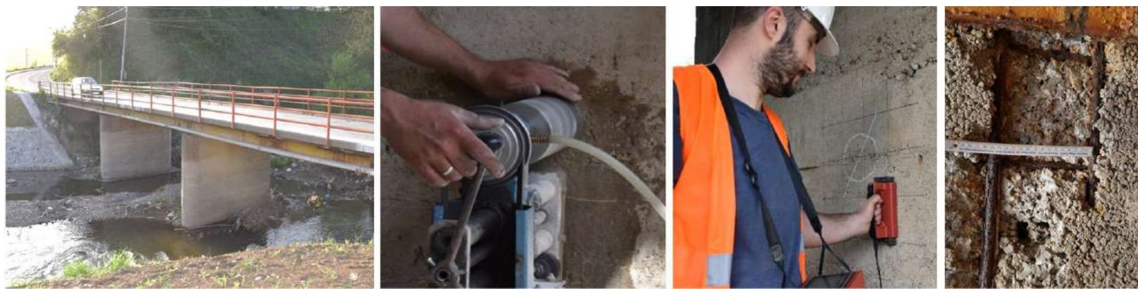
Слика 13. Испитивање стања уграђеног материјала моста у Илијашу
